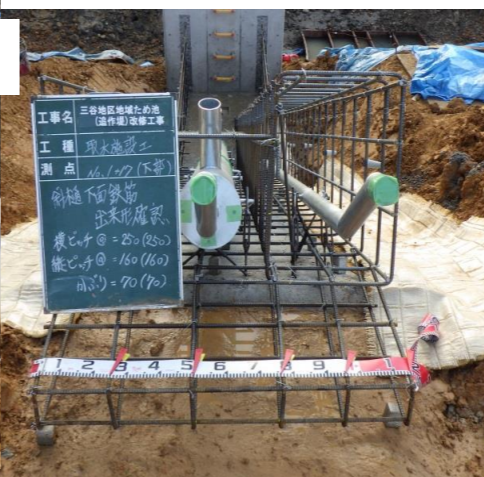
鉄筋組立確認中。
