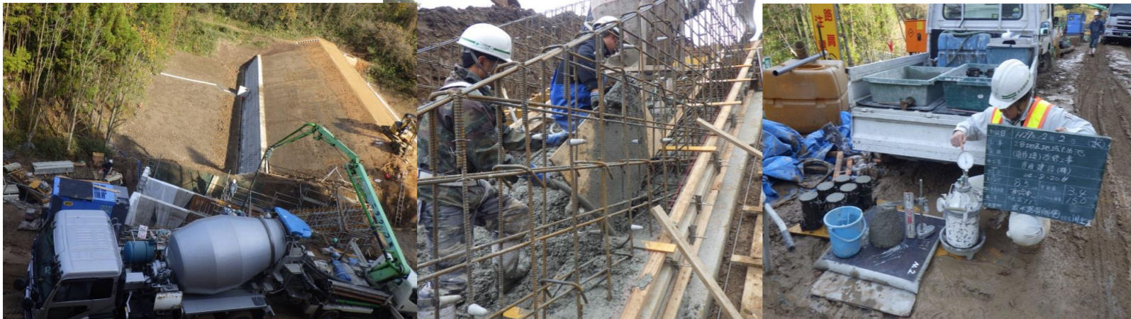
↑ ← コンクリートの品質を確認している状況です。
